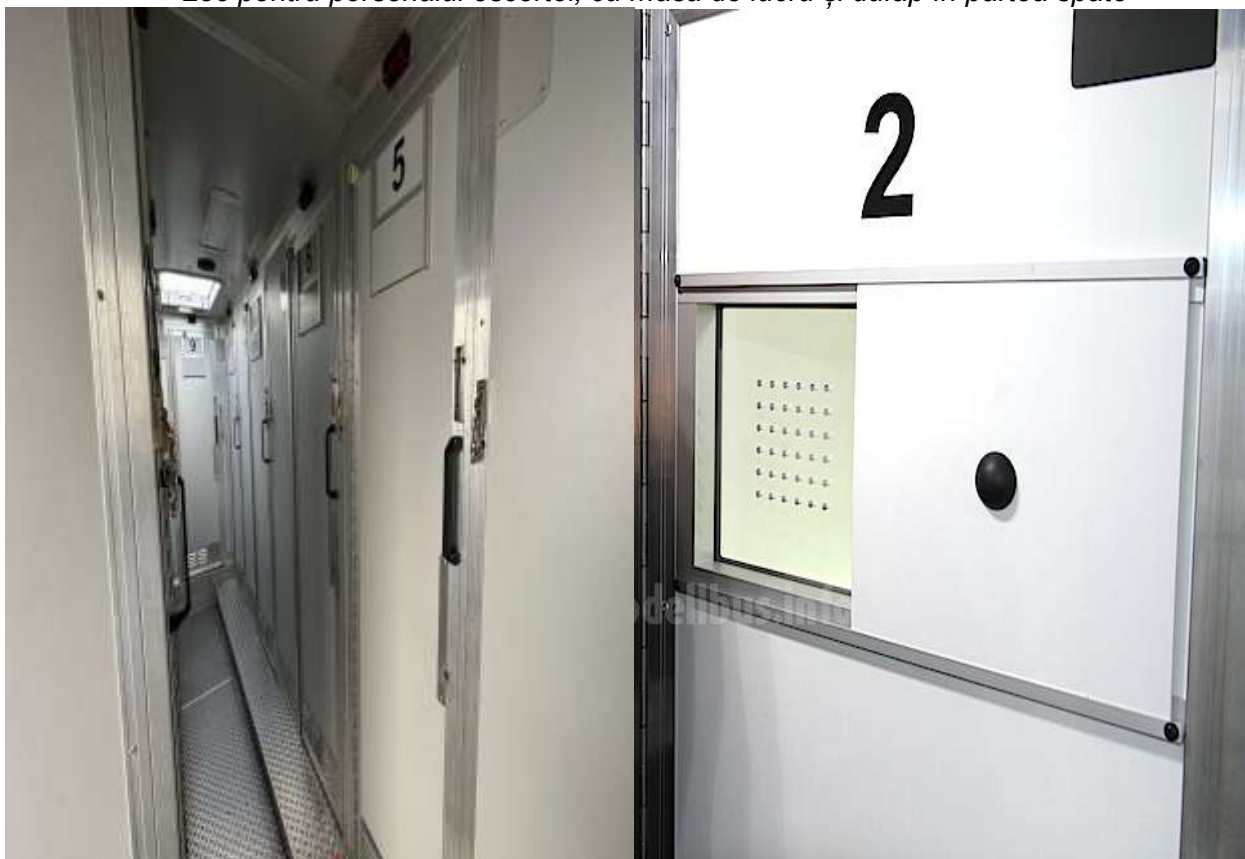
Aspectul culoarului dintre celule, ușile celulelor și oberlihtul celulei
